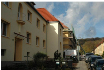
Bilder aus der Zeit der Umbaumaßnahmen
